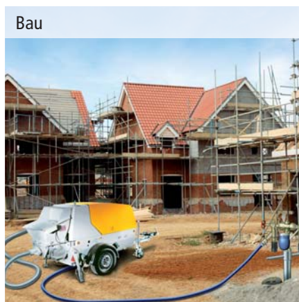
Bereitstellung einer Bauwasserversorgung
