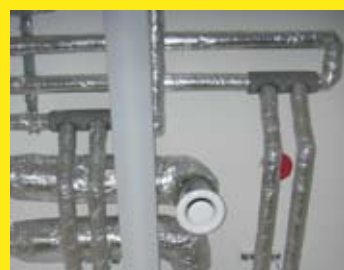
Installierte KHS-Venturi-Strömungsteiler
