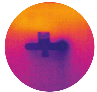
Mischarmatur angebunden über ThermoTrenner.
