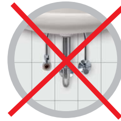
2. keine Demontage des Eckventils
