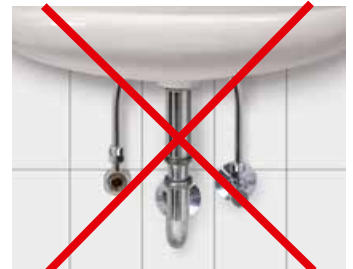
2. keine Demontage des Eckventils
