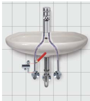
2. Zu kürzende Rohrlänge anzeichnen
