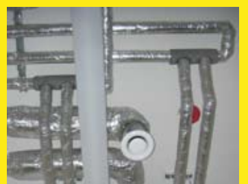
Installierte KHS-Venturi-Strömungsteiler
